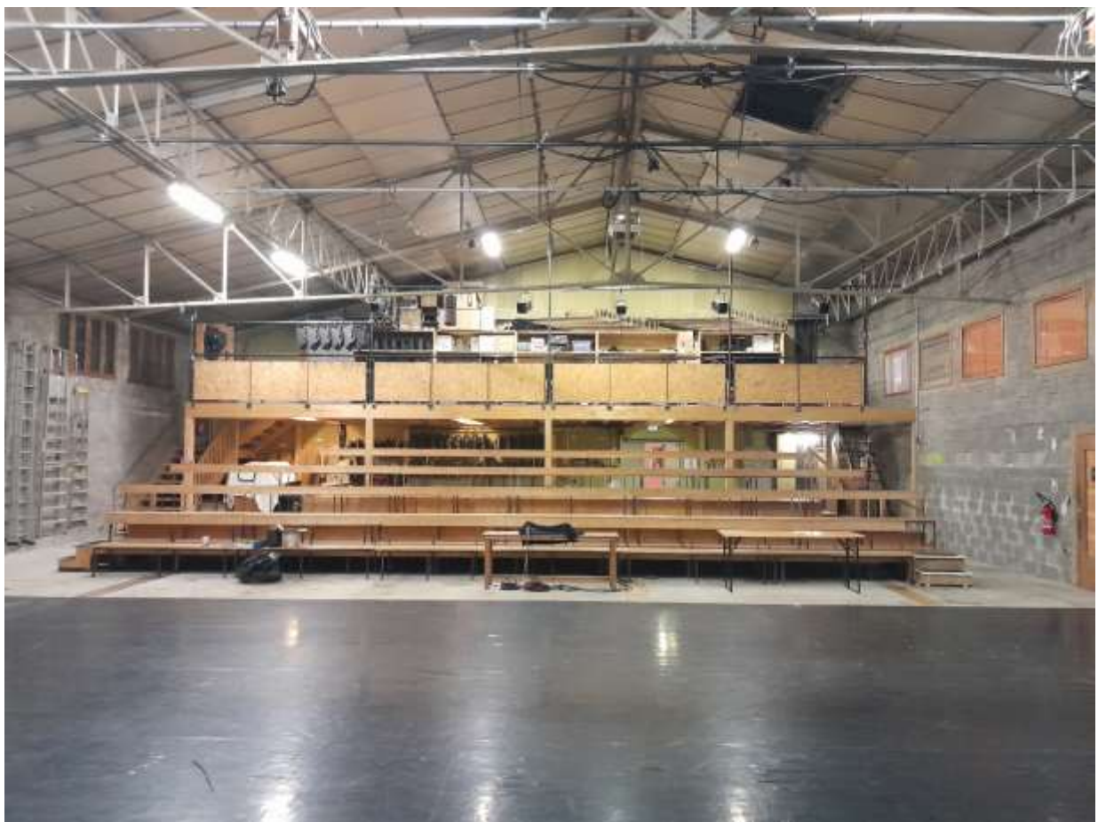
Une mezzanine technique permet d'éclairer la scène frontalement
